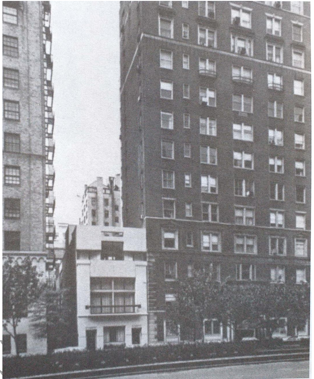
خانه‌ی شهری، خیابان پارک، نیویورک سیتی؛ رابرت استرن (۱۹۷۵).
