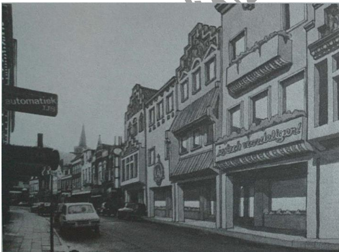
گزینه‌ای دیگر برای خیابان هلند؛ چندین ساختمان شبیه به زمینه‌ی اصلی به سیمای خیابان الحاق شده است. (موتاز عکس: آنگوس مک دونالد)
