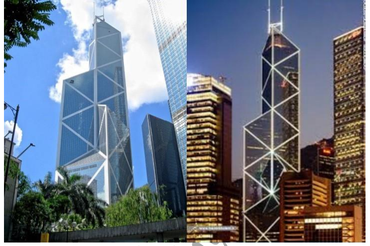
سیستم قاب فضائی بانک هنگ کنگ سیستم دایا گرید، سوئیس ری لندن
