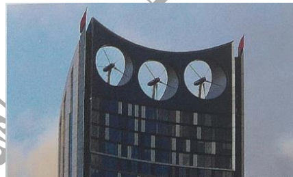
نگاره ۲-۲۴: برج استراتا در لندن- قرار گیری توربین در سقف. به شیب دار شدن فرم سقف جهت هدایت جریان باد دقت کنید.
