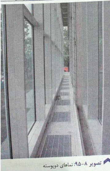
تصویر ۱۷۹-۸: جزئیات دریچه‌های ورود و خروج هوا در نما
