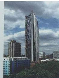
نگاره ۲-۲۴: برج استراتا در لندن- قرار گیری توربین در سقف. به شیب دار شدن فرم سقف جهت هدایت جریان باد دقت کنید.
