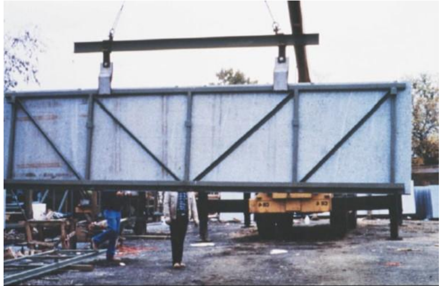
شکل ۴- ۲۵- پانل دیواری پرده‌ای پیش‌ساخته سنگی
