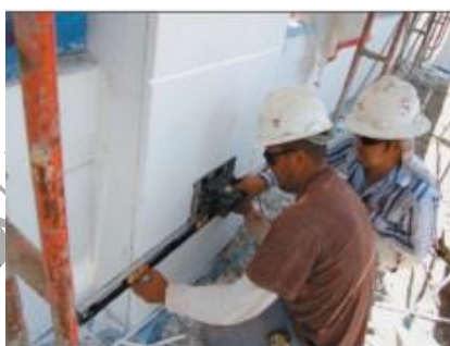
شکل ۶-۱۶- ایجاد شیار بر روی صفحات عایق بعد از صاف کردن
