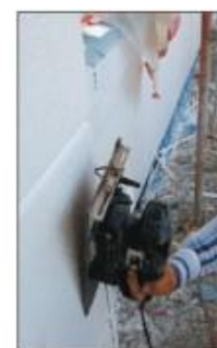
شکل ۶-۱۶- ایجاد شیار بر روی صفحات عایق بعد از صاف کردن
